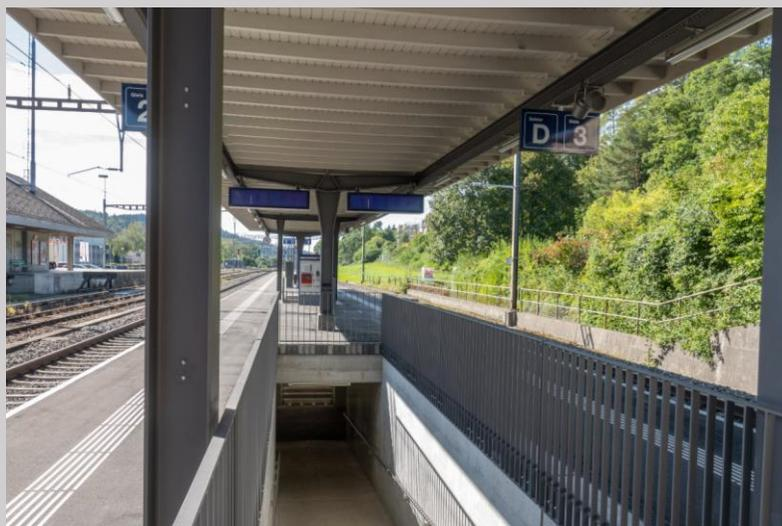
Das Mittelperron des Bahnhof Elgg wurde umgebaut. Hierbei wurde der Perron auf P55 Niveau erhöht und die Publikumsanlagen auf den aktuellen Stand der Technik sowie Vorschriften gebracht. Damit verbunden war auch eine Anpassung des bestehenden Perrondaches und die Zugänge zum Mittelperron.
